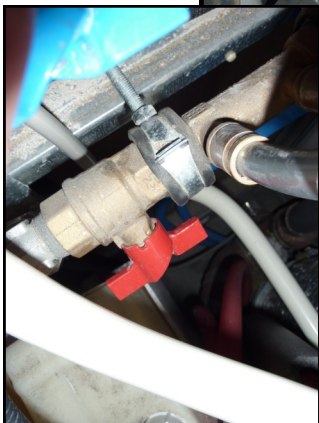
6) LUKNING VARMT VAND TIL HANEN
