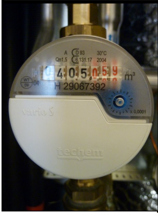
1) FORBRUGSMÅLER KOLDT VAND
