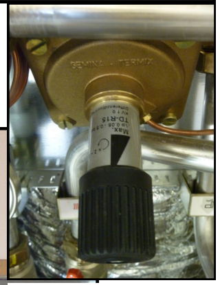
3) REGULATOR UD-GANGSTEMPERATUR VARME
